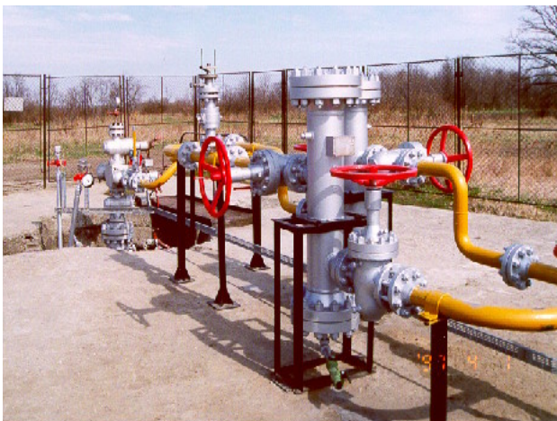
4.3.2 sz. ábra 5/2 μm-es kaszkádszűrő működése
