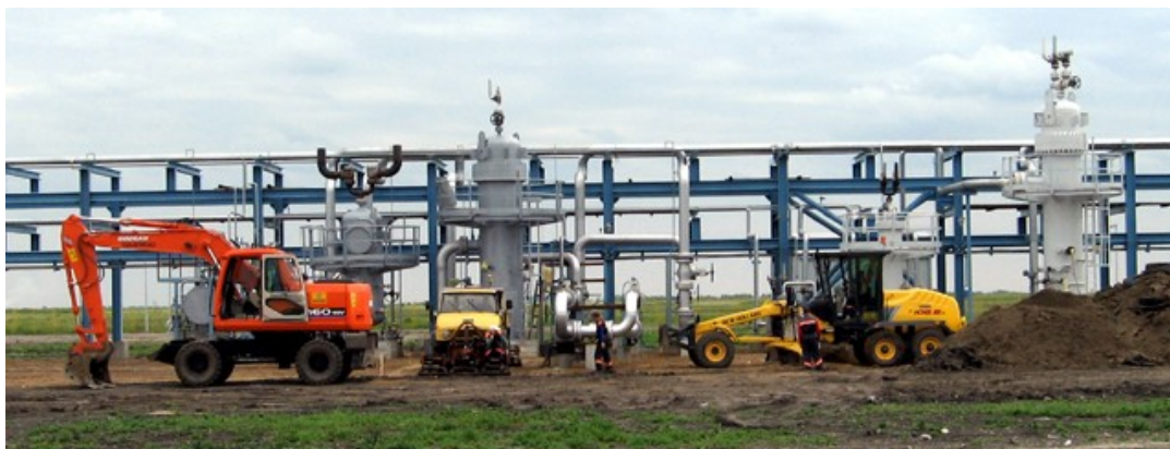
10. sz. ábra Épül a földgáz tisztító állomás 5 millió m 3 /nap
